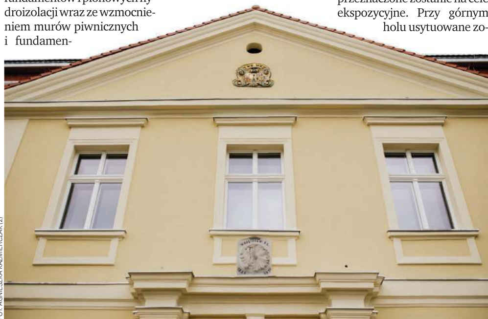
Budowlanci zakończyli już prace przy frontowej ścianie
