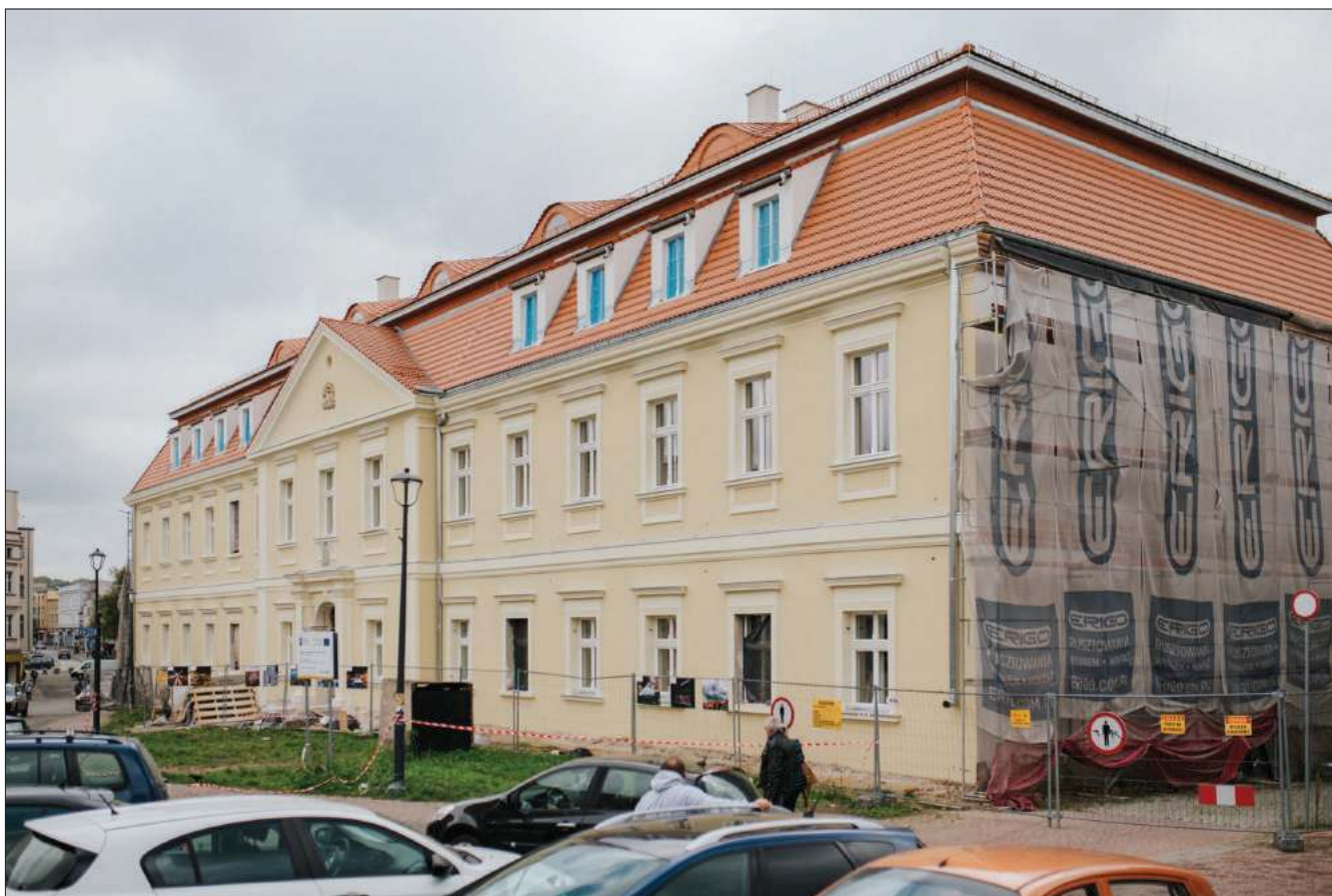
Wodzisławski magistrat przewiduje, że zakończenie prac budowlanych prowadzonych w pałacu będzie miało miejsce wiosną przyszłego roku
