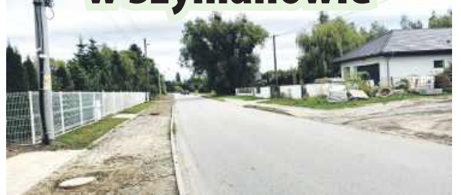
Modernizacja drogi powiatowej nr 1370D
