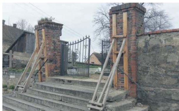
Drewniane rusztowanie podpira słupy już kilka miesięcy
