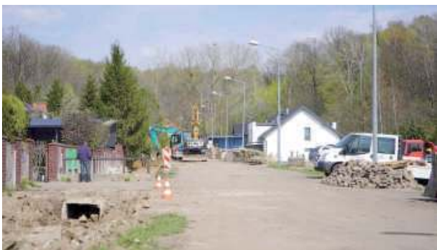
Prace nad modernizacją ul. Sybiraków trwają już od jakiegoś czasu. Niebawem mieszkańcy i turyści będą mogli komfortowo dojeżdżać do swoich posesji czy do stoku
