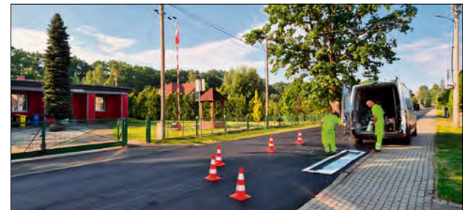
W Dąbrowie położony został nowy asfalt na odcinku 400 m.
