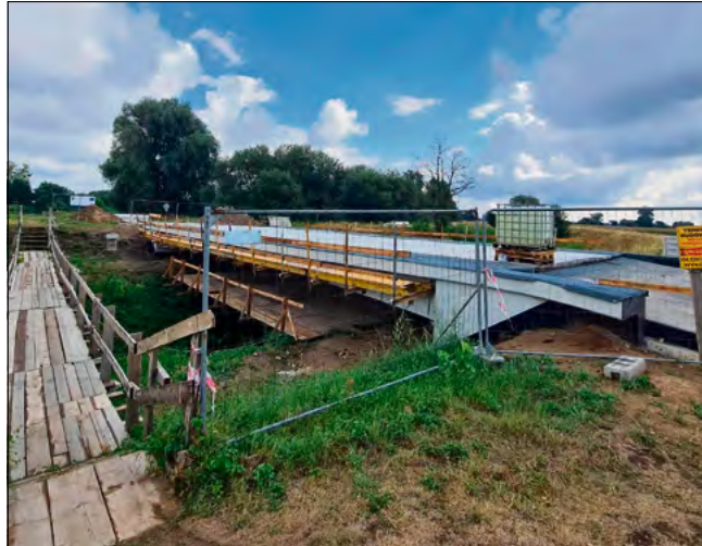
Inwestycja w Naroku obejmuje także przebudowę blisko 300-metrowego odcinka drogi wojewódzkiej nr 464.
