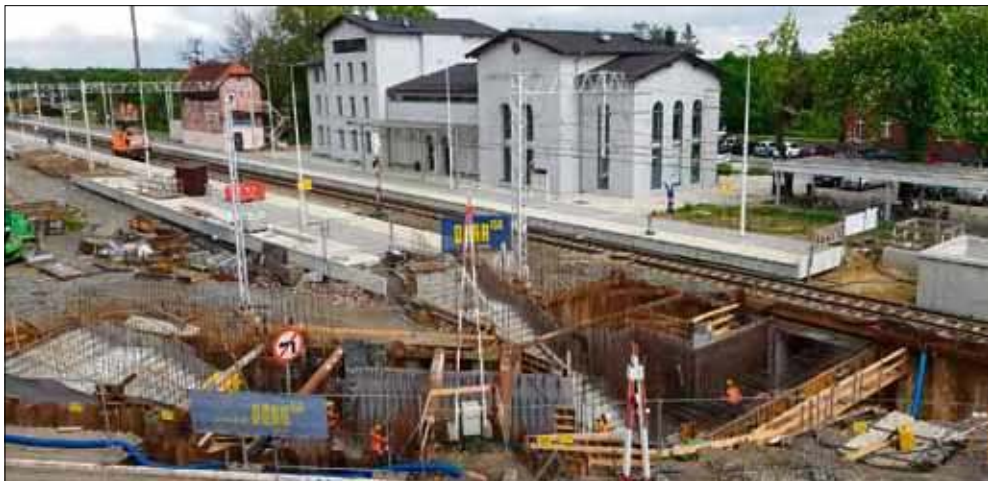
Tak plac budowy wyglądał 20 maja...
