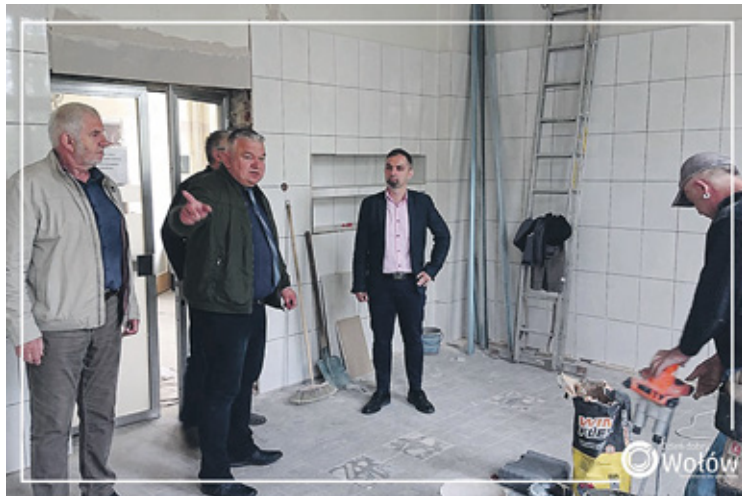
Jeszcze trzy lata temu w Wołowie, na oddziale wewnętrznym robiono remonty.
