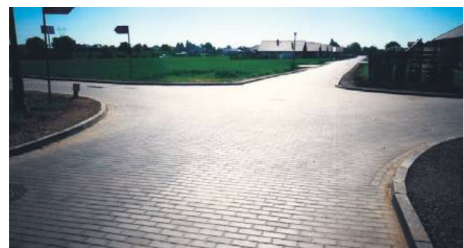
Nowa droga kosztowała prawie 3 mln zł brutto.
