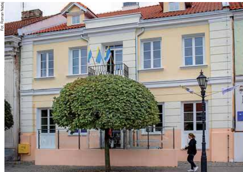
Odnowiona kamienica przy ul. Rynek 13
