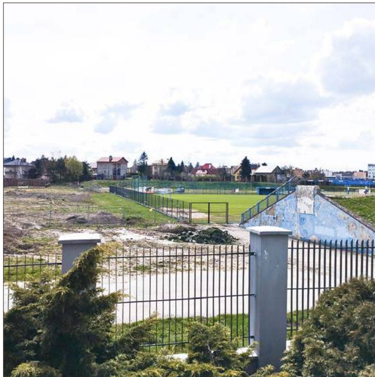
Basen mógłby powstać w miejscu wyburzonej trybuny.
