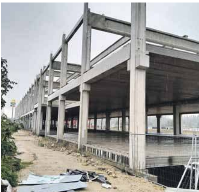
Na budowie Galerii Podhalańskiej hula wiatr, ale w 2023 roku mają tu już działać sklepy.
