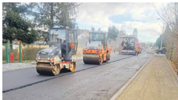
Wylano już warstwę wiążącą na odcinku Biały Kościół – Gębczyce. Fot. PZD w Strzelinie
