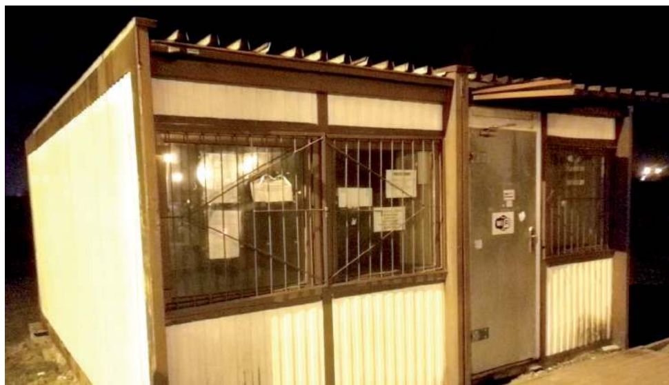
Kiedy w 2009 r. miasto zdecydowało o nowej lokalizacji dworca PKS, radziniacy mówili o tym miejscu z przekąsem „wygwizdów”. W okresie mrozów, deszczów czy silnych wiatrów przez kilka miesięcy podróżni nie mieli się gdzie schować przed aurą. Sprawę załatwiło postawienie blaszanego kontenera. Miał to być obiekt tymczasowy
