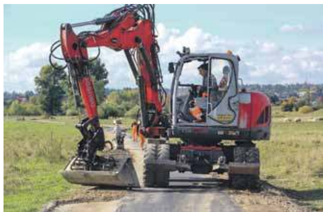
Ostatnie poprawki - i można jechać. Już nie koparką, ale rowerem.
