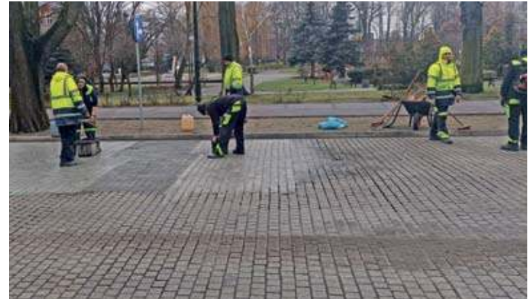
Na ul. Bankowej trwają prace naprawcze
