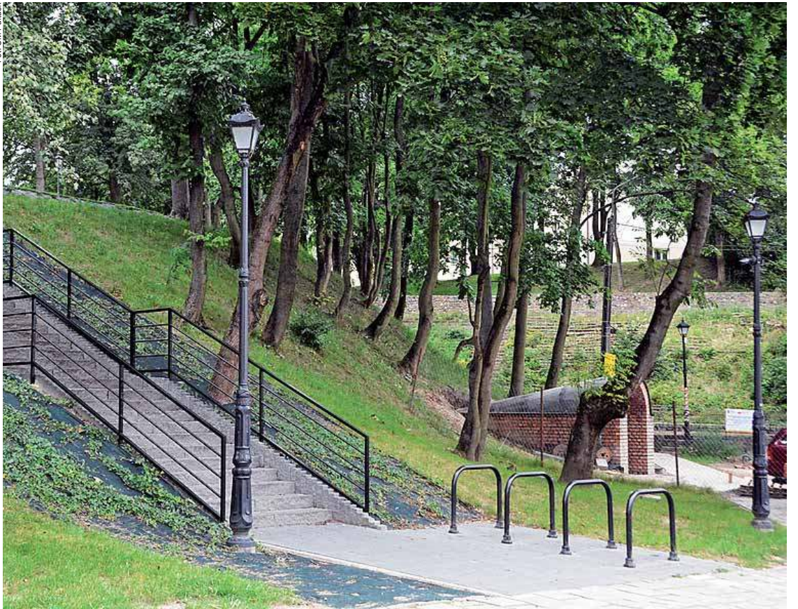
Dzięki wsparciu Mazowsza wyremontowane zostaną historyczne piwnice i korytarze wewnątrz Wzgórza Abrahama w Pułtusku
