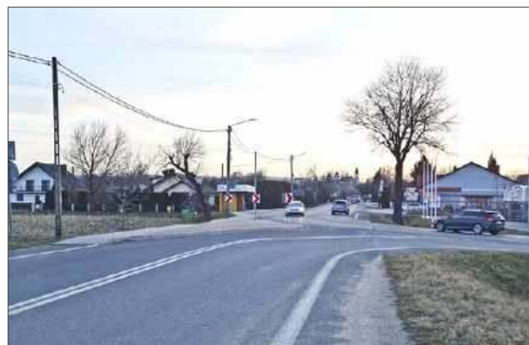
Na tym skrzyżowaniu zbudowane zostanie jedno z rond.
