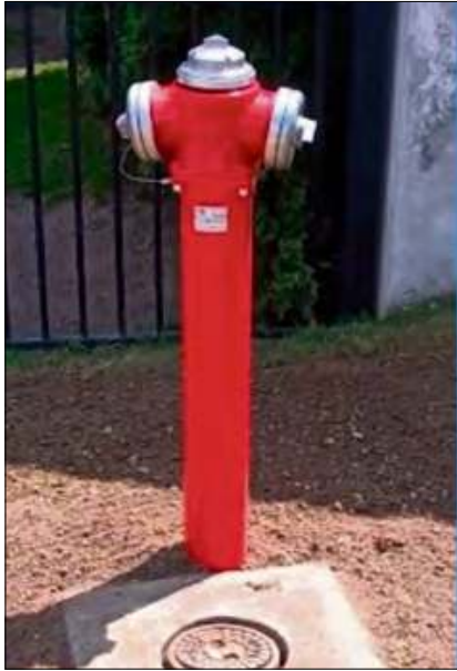
W gminie Strzeleczy zamontowano nowe hydranty.
