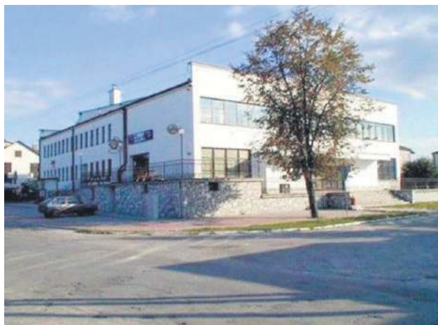
Po zakończeniu inwestycji budynek ośrodka kultury będzie nie tylko cieplejszy, ale też bardziej estetyczny. Fot. UMiG Józefów
