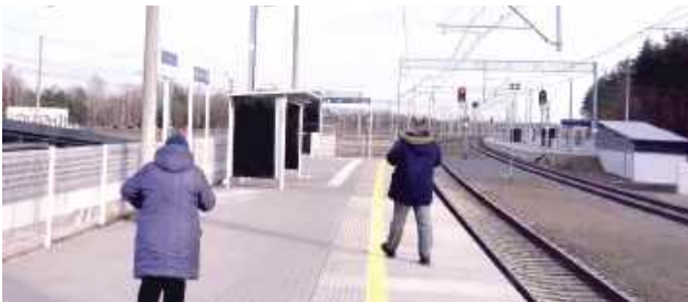
Peron 1. Białej Podlaskiej Wschodniej, a na jego początku schody do przejścia podziemnego. Po prawej w głębi peron drugi
