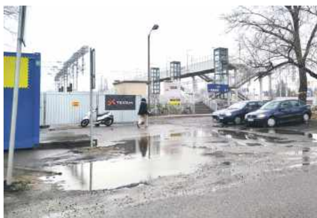
Kolej obiecuje rozwiązać problem kałuż na drodze na perony
