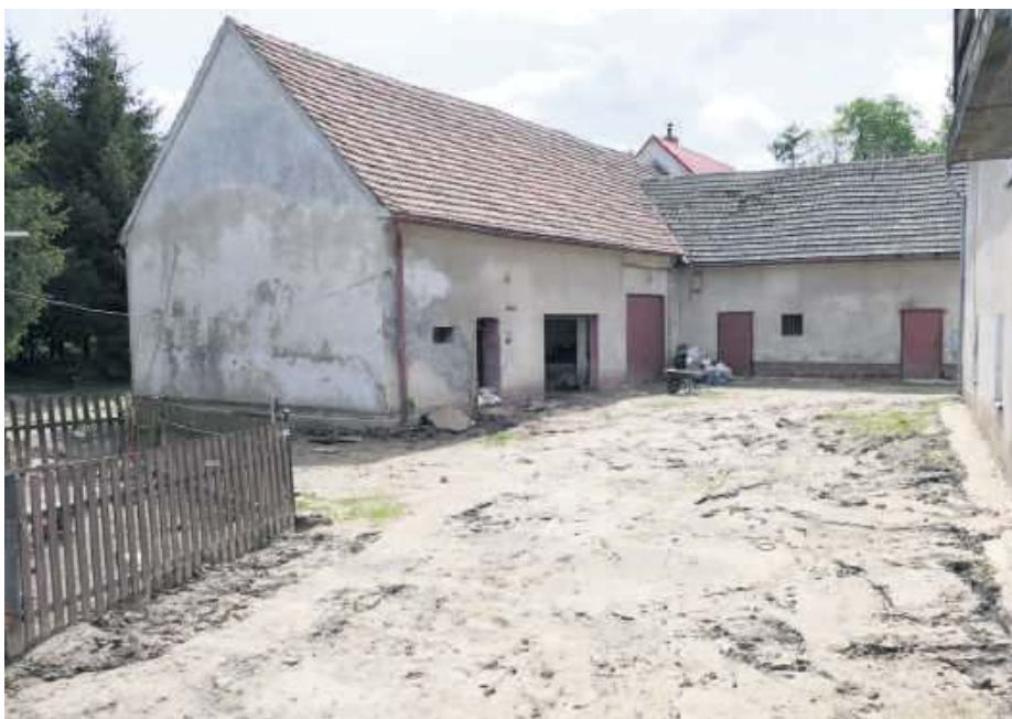
Tydzień wcześniej na podwórku pana Marcina zalegało kilkadziesiąt centymetrów błota. Mimo że zostało wstępnie uprzątnięte, to do stanu sprzed powodzi jeszcze wiele brakuje...
