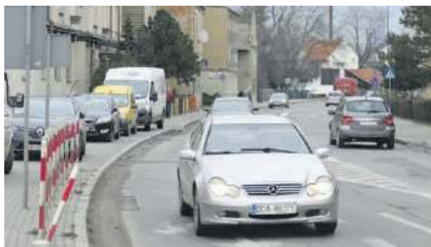
W ramach kompleksowego remontu ulicy Wolności w Strzelinie przewidziano wymianę sieci gazowej, wodociągowej i przebudowę chodników
