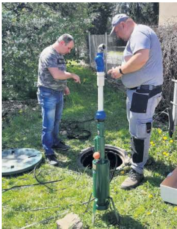
Wymiana pomp przebiega sprawnie
