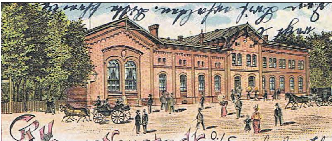
Jeszcze długo po II wojnie światowej głównym węzłem zbiorowego transportu Prudnika był dworzec kolejowy. Kolej z czasem zaczęła ustępować transportowi autobusowemu. Obecnie cały lokalny transport pasażerski przeżywa regres.
