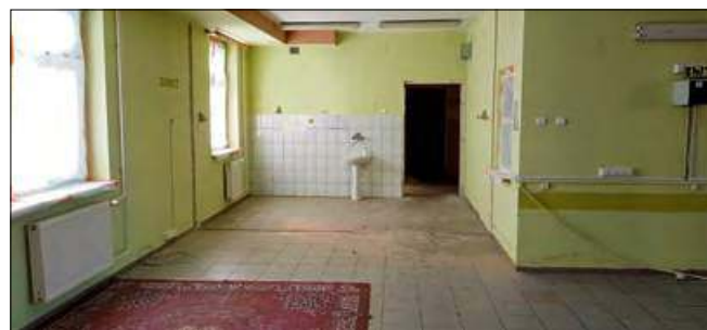
Prace przy budowie kuchni już ruszyły.
