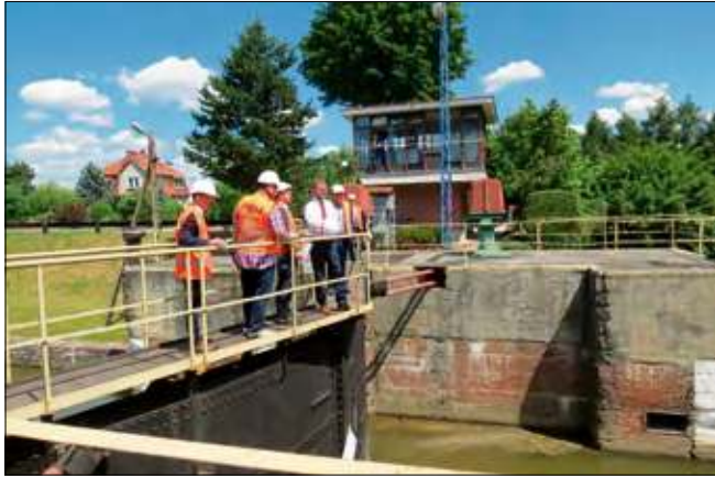
Starą śluzę oraz miejsce budowy nowej wizytowali ważni goście z wiceministrem na czele.
