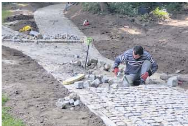
W ubiegłym tygodniu trwały ostatnie prace na alejce prowadzącej do głazu
