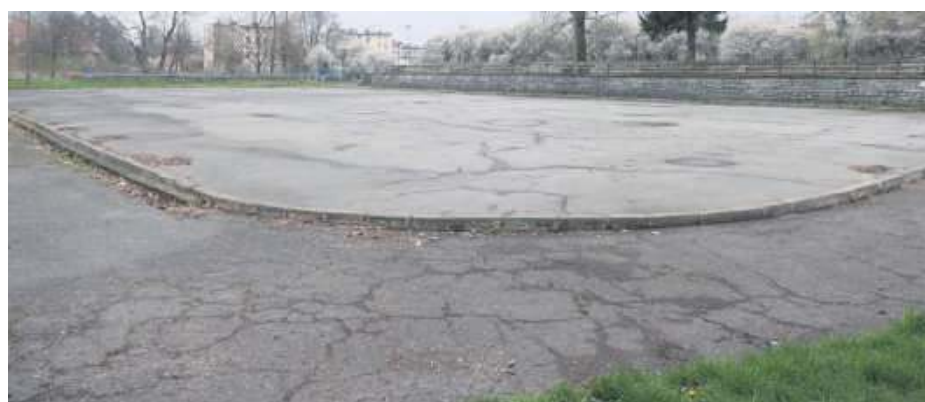
W pierwszym etapie na terenie dawnego lodowiska w Strzelinie zostanie zamontowane nowe oświetlenie
