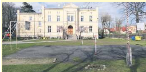
Przy Szkole Podstawowej w Wawrzyszowie powstanie wielofunkcyjne boisko
