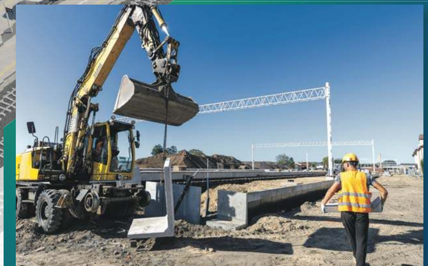
Montaż ścian peronowych
