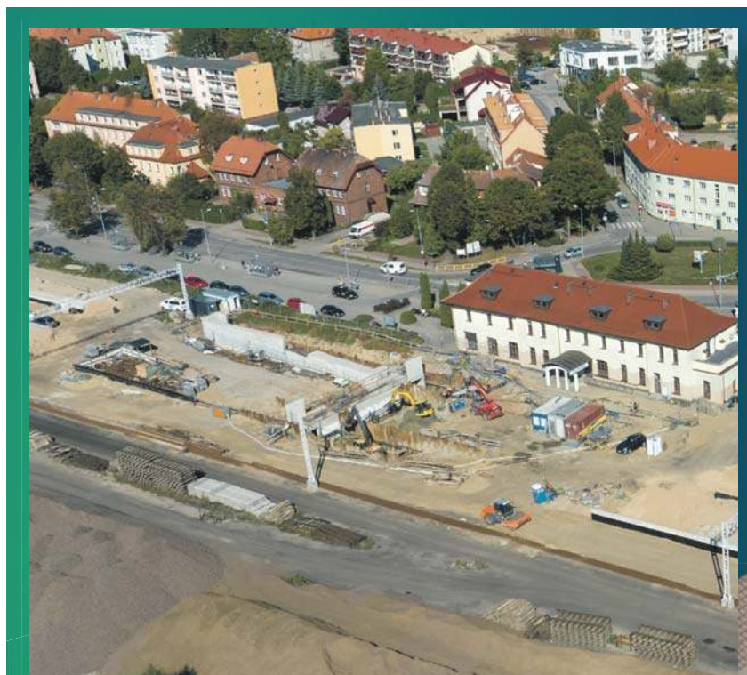
Przebudowa stacji Giżycko
