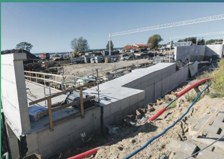
Budowa przejścia podziemnego
