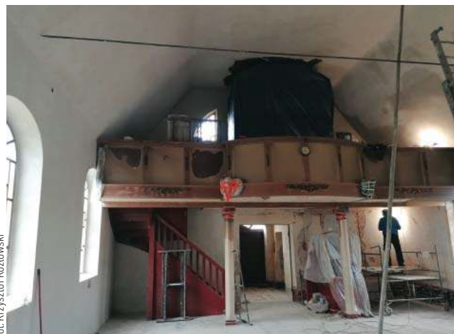
Wyczyszczono i otynkowano już ściany w kościele, położona została też cała nowa instalacja elektryczna
