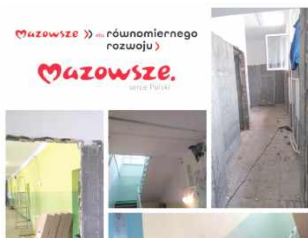
Budynek szkoły w budowie
