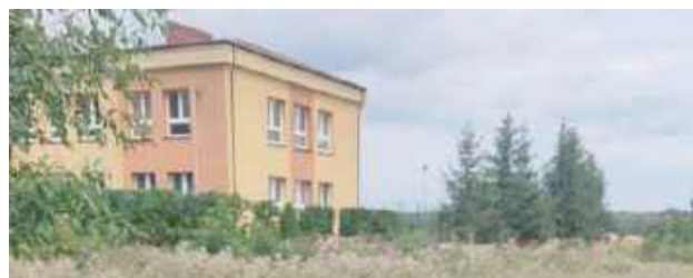
Przy budynku szkoły powstanie wreszcie parking
