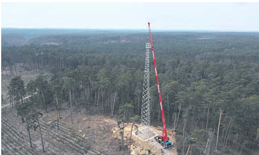
42-metrowa konstrukcja powstaje w Woziwodzie, na wzniesieniu po lewej stronie (patrząc od strony Tucholi).
