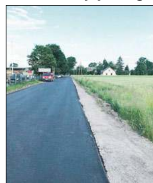
Wyremontowano m.in. też odcinek Dubów-Wola Dubowska o długości 1,040 km
