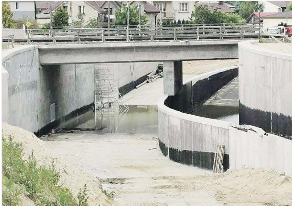
Mieszkańcy obserwujący postępy prac wokół przejazdu pod torami w ciągu ulic Lubelska/Witoroska pytają o zbierającą się tam wodę i parametry przejazdu
