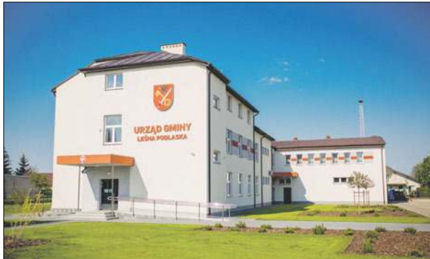
Sztandarową inwestycją połowy obecnej kadencji był projekt dotyczący „Termomodernizacji budynków użyteczności publicznej”. Wyremontowano w tym czasie m.in. urząd gminy
