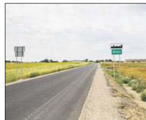
W czerwcu 2020 roku zakończono pierwszy odcinek budowy drogi gminnej Witulin – Witulin-Kolonia o wartości 1 336 120, 71 zł. Z czego dofinansowanie z dotacji Funduszu Rozwoju Dróg Samorządowych wyniosło 668 060 zł
