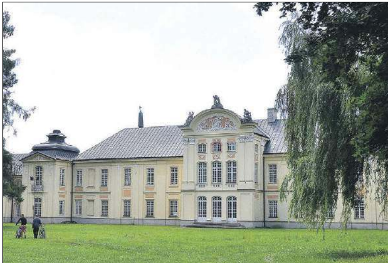
Fasada północna po renowacji w 2008 roku wyglądała tak
