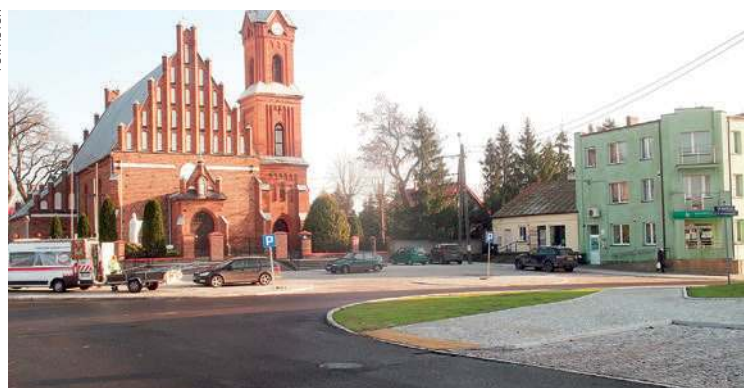
Rynek w Dzierzgowie. Układ komunikacyjny na tym placu przebudował - wraz z modernizacją dróg dojazdowych i remontem mostu - powiat mławski dzięki rządowej dotacji
