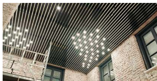
Kamienica na ul. Grunwaldzkiej
