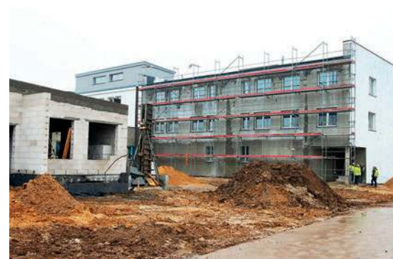
Przebudowany budynek starego oddziału zakaźnego
