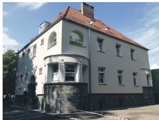
„Bajka” zyskała nową elewację, instalacje wewnętrzne oraz funkcjonalną przestrzeń dla dzieci
