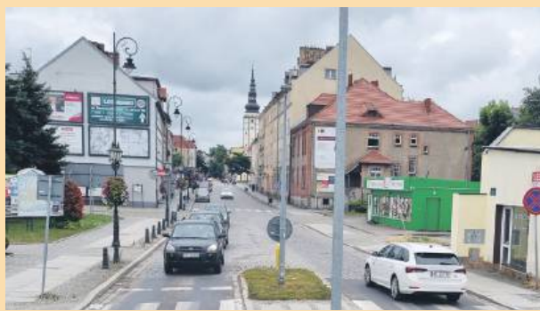
Podczas przebudowy ronda przewidziane jest całkowite zamknięcie wlotu od ul. Kościuszki na cały okres trwania robót
