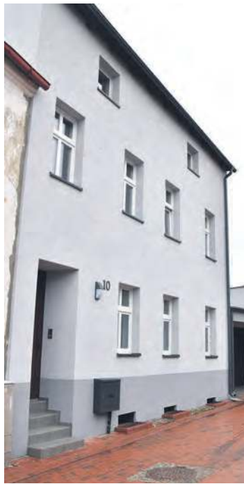
Budynek przy ul. Murowej 10.
