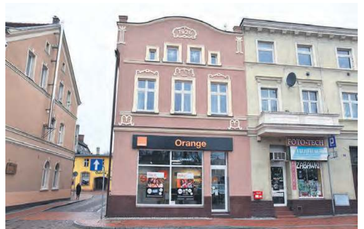
Kamienica przy placu Wolności 1.
