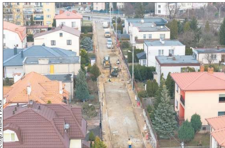
Prace na ulicy Małej na osiedlu Skarpa
