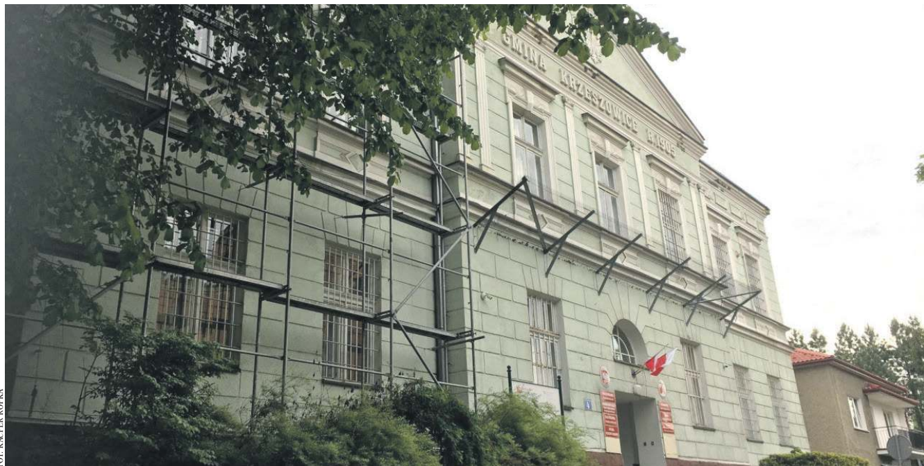
Remontowany budynek urzędu przy ul. Grunwaldzkiej w Krzeszowicach
