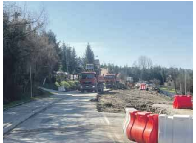
Remont osuwiska w ciągu ulicy Zakopiańskiej.
