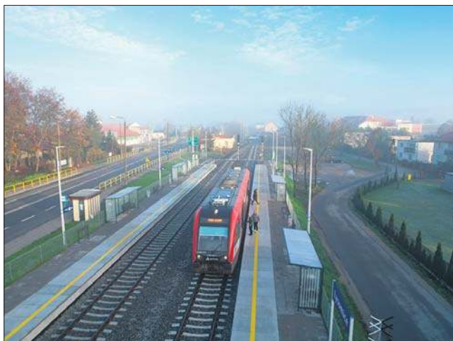
Zmodernizowany przystanek Łysomice na linii z Grudziądza do Torunia
