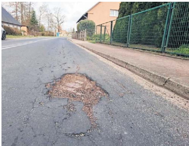
Jeden z wniosków dotyczy trasy przebiegającej przez Kąkolewo. Tak ten odcinek wyglądał w marcu tego roku
