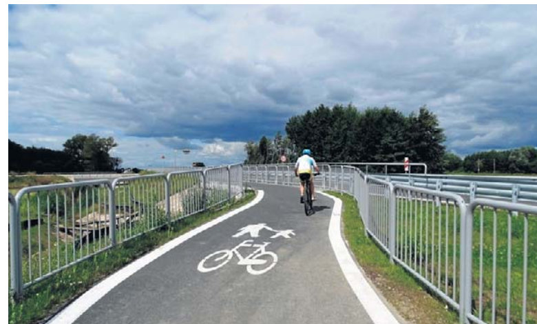
Droga warta prawie ćwierć miliarda złotych jest już przejezdna. To największa taka inwestycja drogowa w powiecie poznańskim
