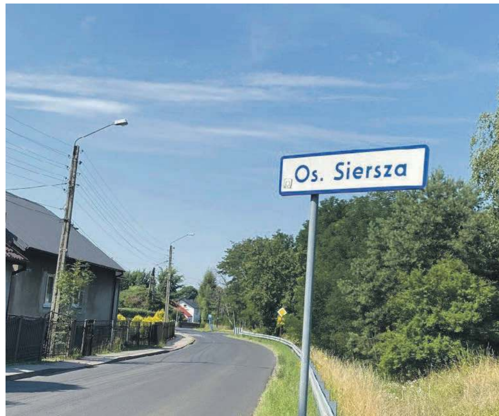
Osiedle Siersza wymaga odwodnienia, ale realizacja przedsięwzięcia natrafia na przeszkody
