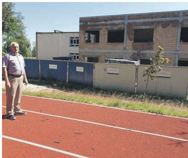
Sołtys Zalas Henryk Woszczyński przy powstającym budynku przedszkola
