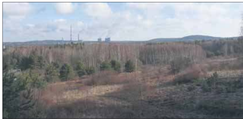
Elektrownia z oddali
