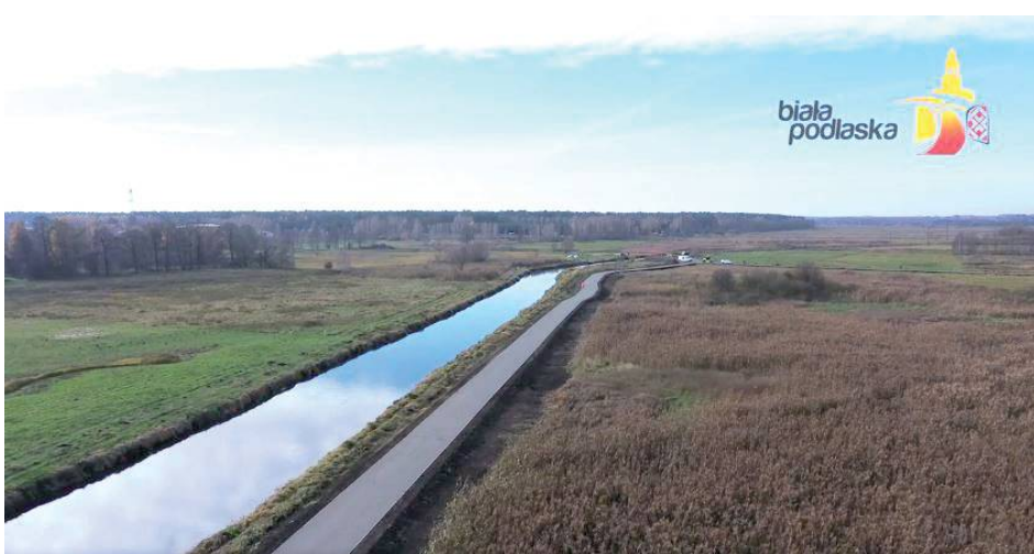
Etap zachodni to droga łącząca granicę miasta, gdzie ponad 2 km ścieżki zostało wykonane przez gminę Biała Podlaska. Prowadzi wzdłuż rzeki Krzny, do pawilonu edukacyjnego przy ul. Żurawiej
