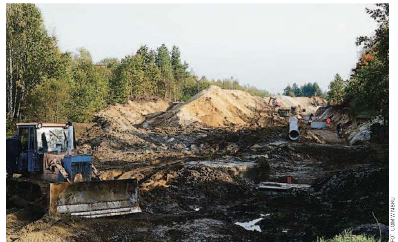
Budowany łącznik będzie miał długość 970 metrów i znacznie usprawni komunikację pomiędzy obwodnicą a lokalnymi drogami
