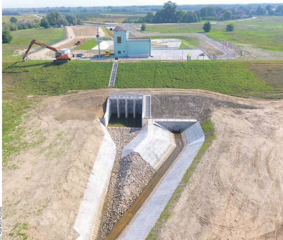
Budowa nowej pompowni „Koćmierzów”
