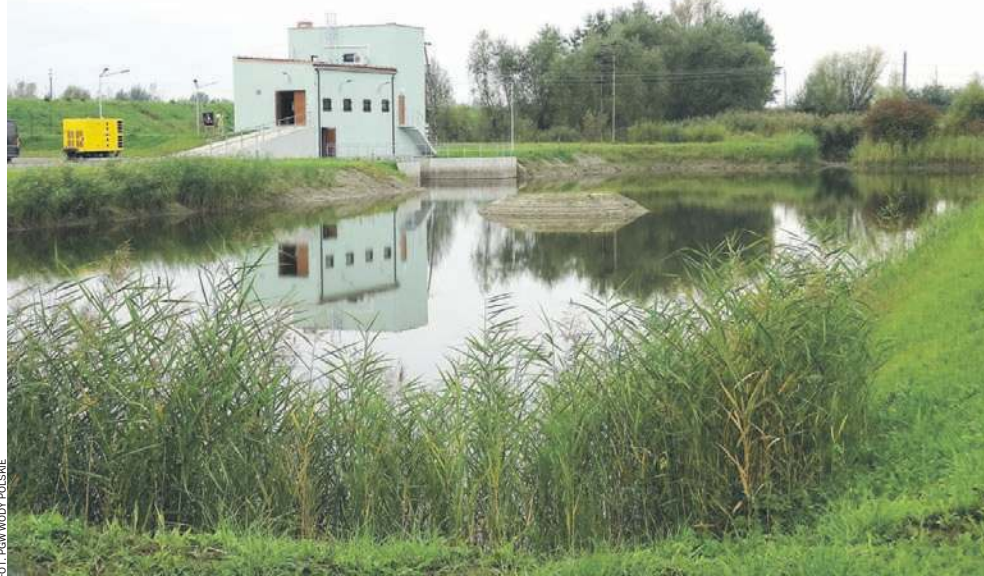
Przebudowa i rozbudowa pompowni „Nadbrzezie”
