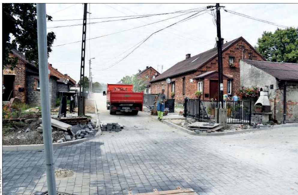
Obecnie na osiedlu trwają prace związane m.in. z budową dróg wewnętrznych
