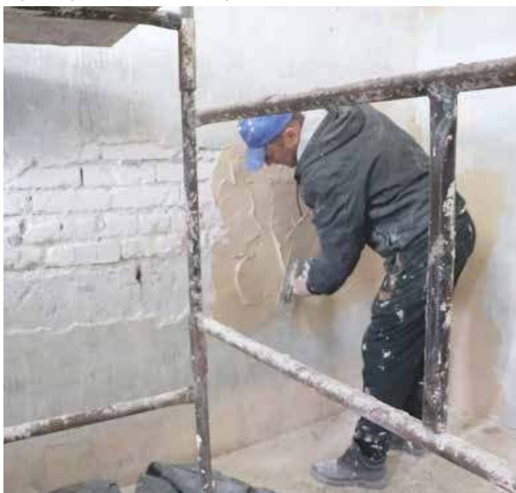
Remont prowadzony był w szatniach oraz łazienkach w budynku klubowym Pomorzanina
