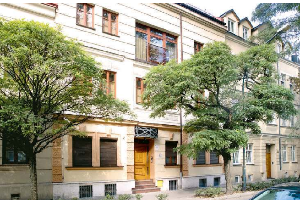
W należącej do Mariana Banasia kamienicy przy ul. Krasickiego 24 w Krakowie miał być dom pielgrzyma.
