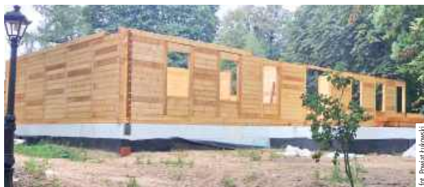
Widoczna jest już drewniana konstrukcja budynku, dzięki czemu coraz łatwiej dostrzec jego docelową bryłę
