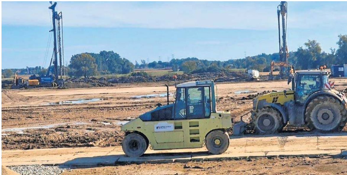
W Opolu Wrzeskach powstaną dwie wielkie fabryki. Budowa jednej ruszyła, inwestor drugiej na razie zmienił właściciela.
