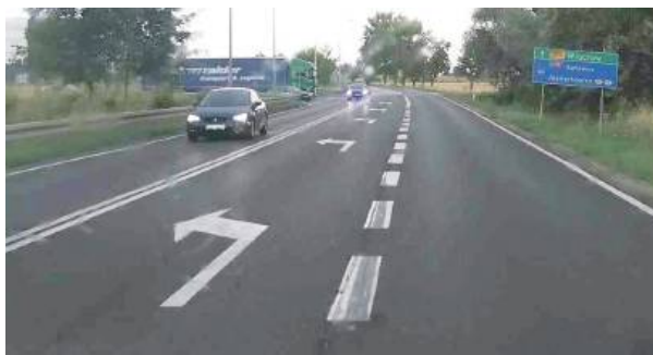
Jednym z przebudowywanych węzłów będzie ten na drodze nr 395 obok Krajkowa
