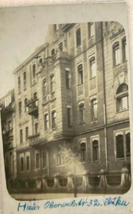
■ Kamienica przy Oberwallstraße 32, dzisiejszej ulicy Drzymały
